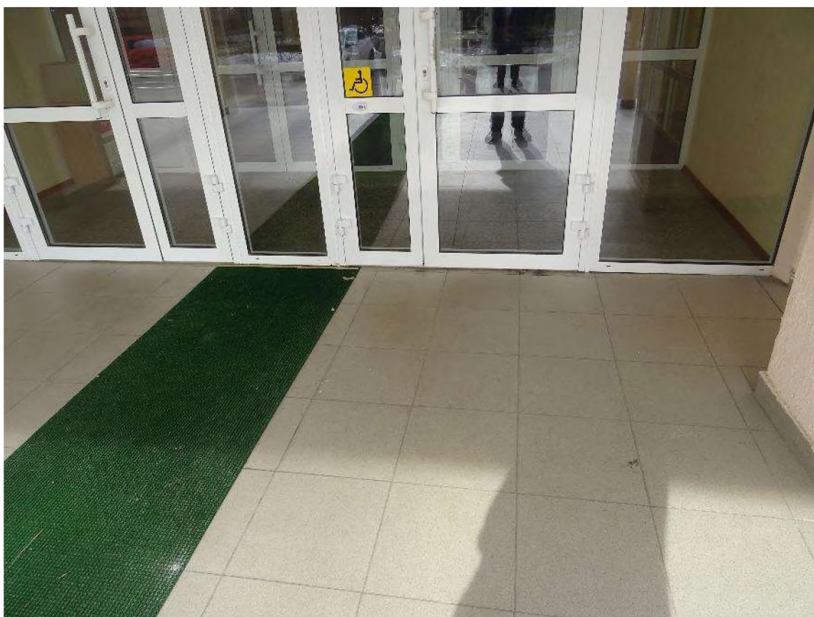
Рисунок Б3 Вид покриття входної групи навчального корпусу №4
