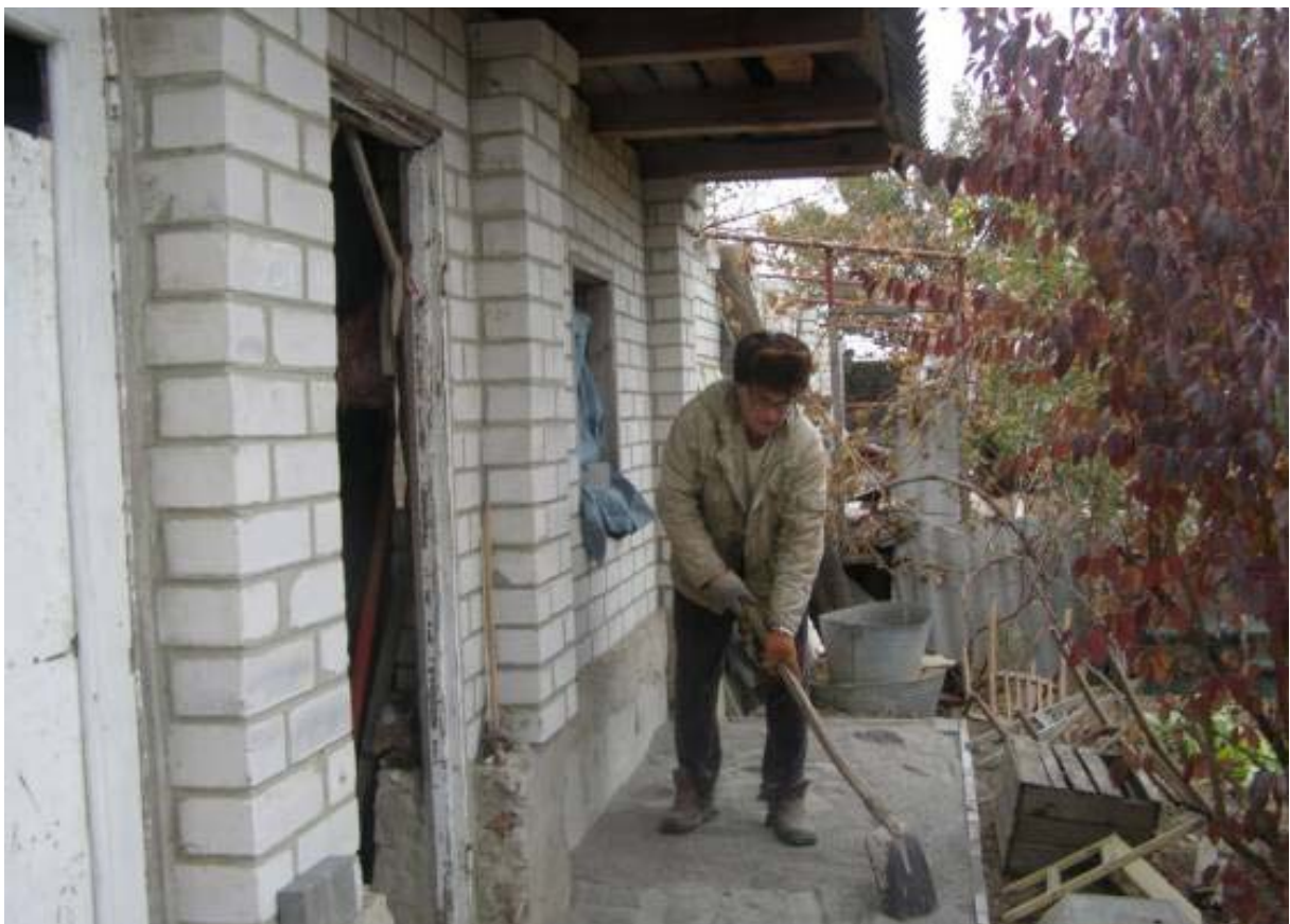
Навіть у 79 років бере гору бажання щось самому будувати: в цьому випадку – бруківку перед допоміжною будівлею у дворі – «хатинкою».
