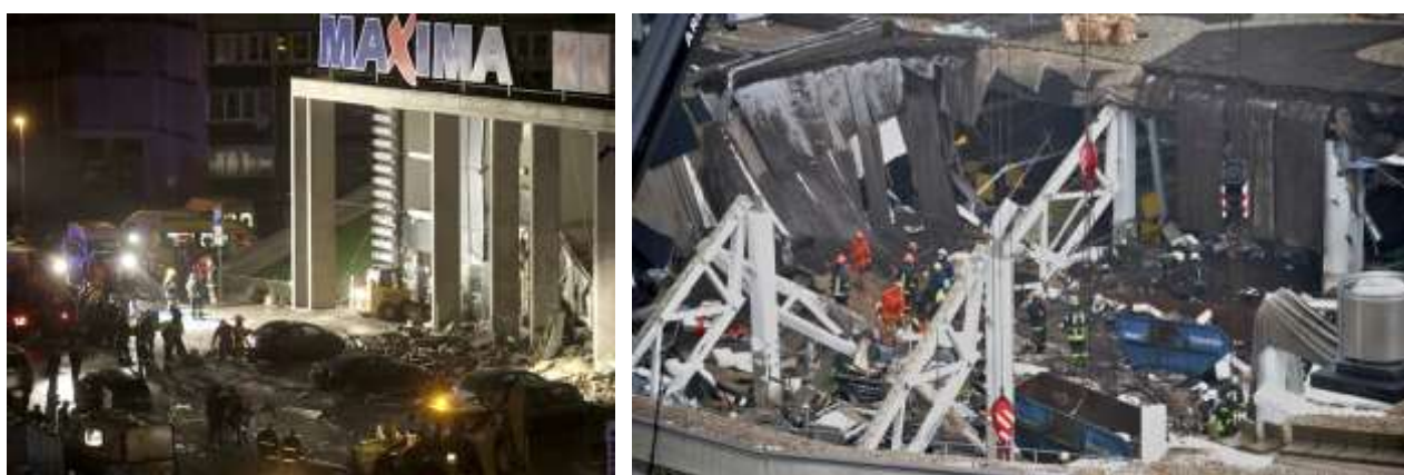
Рис. 1. Зруйновані стіни і дах торговельного центру «Махіма» у Ризі
