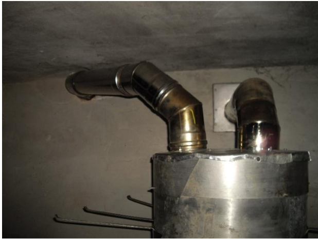
Рисунок 1 – Верхня частини печі з рекупераційним ковпаком та системою відводу підігрітого повітря
