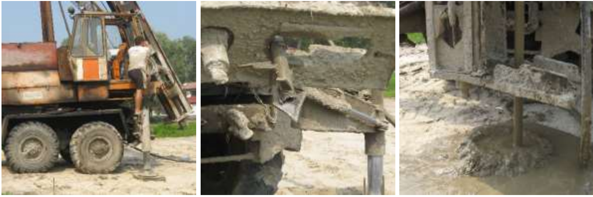
Рисунок 1 - Бурозмішувальна технологія виготовлення ґрунтоцементу
