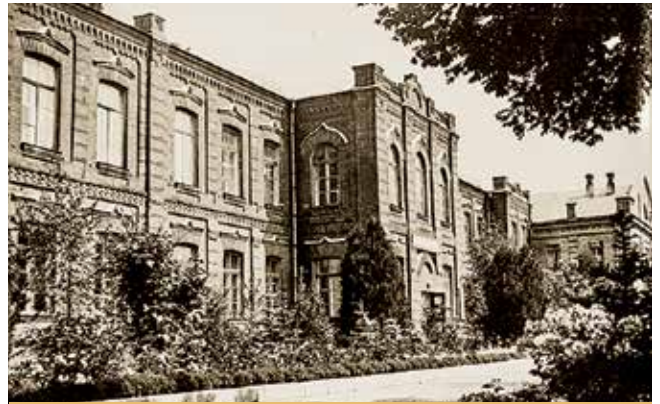
Відбудований другий навчальний («червоний») корпус
